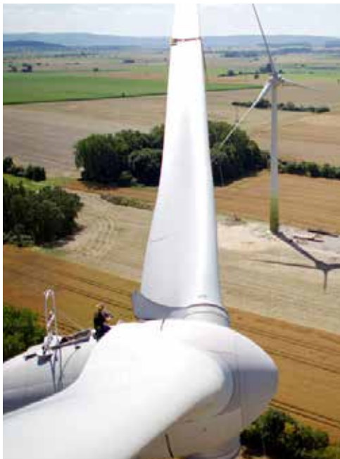
Windpark Wartung (Windwärts Energie)
